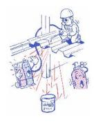
可燃性ガス(アセチレン・LPG など)と酸素をもちいての溶接、溶断作業に必要になります。建設現場では主に、**解体時の溶断作業**に使用したり、設備関係では、**銅管パイプのろうづけ作業**をするのに必要になります。この講習では正しい溶接器具の取扱、火炎の調整、火口の交換方法など逆火、爆発事故をおこさない為の正しい取扱を修得します。
